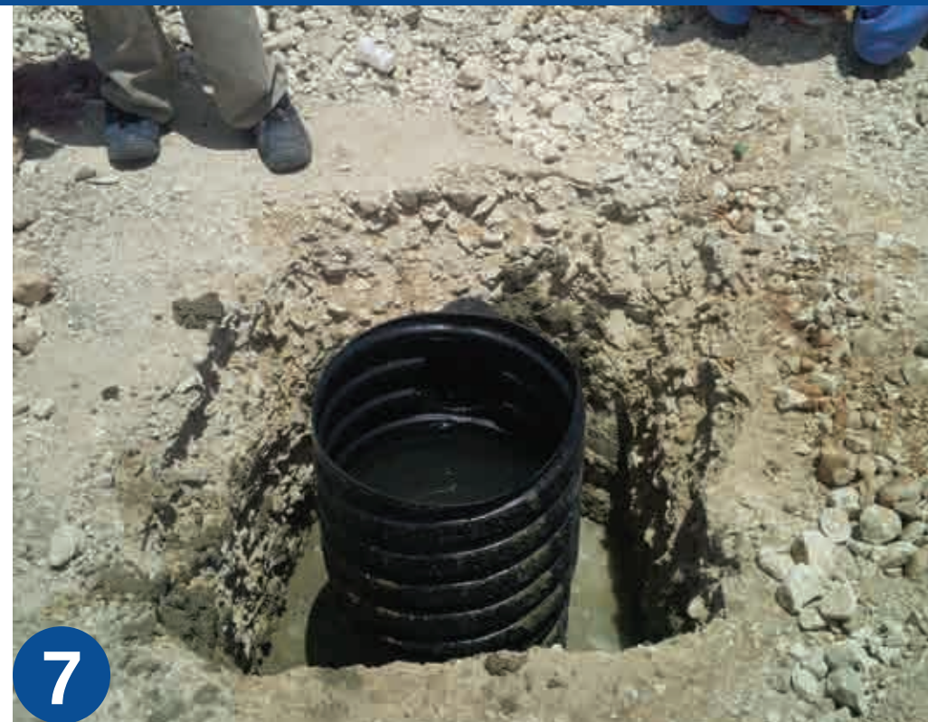
Begin concrete surround pour
