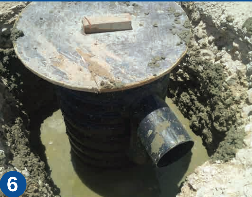
Cover top prior to concrete pour
